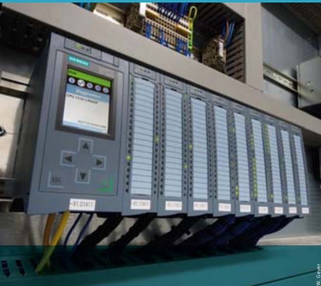
Diagnosemöglichkeit nicht nur für Programmierer: die neue S7-1500 mit Display
